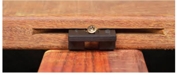
La mise en œuvre des fixations invisibles HardWood Clip® sur des lames standards à chants pleins est réalisable facilement et rapidement
