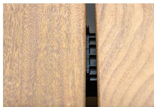
Protection de la lambourde grâce au capotage formé par le dispositif d'emboîtement des deux fixations adjacentes qui recouvre intégralement la lambourde au niveau des espaces entre lames et la rend totalement invisible.
