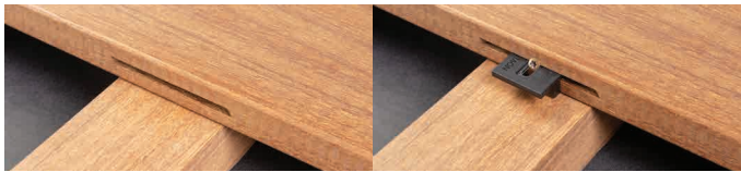
Ter plaatse groeven aanbrengen, met profielgroeffreesmachine (type Lamello®) of bovenfrees.
