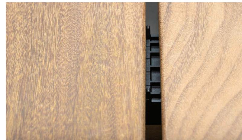
Es bildet dank des Ineinanderschiebens von zwei nebeneinander liegenden Befestigungen einen Rundumschutz des Tragbalkens, sodass der Tragbalken im Bereich der Dielenzwischenräume vollständig abgedeckt wird.
