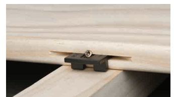
Lokale Nutung, mit Nutfräsmaschine (Typ Lamello®) oder Oberfräse bearbeitet.
