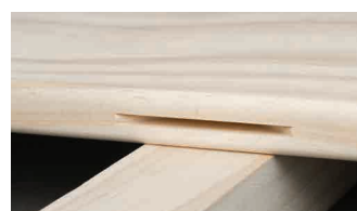
Ter plaatse groeven aanbrengen, met profielgroeffreesmachine (type Lamello®) of bovenfrees.
