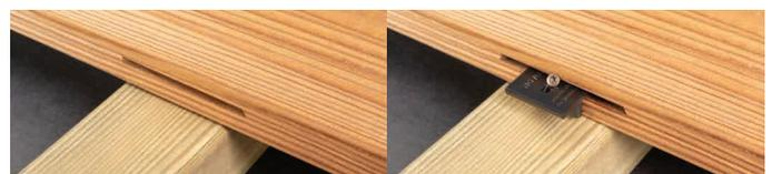
Lokale Nutung, mit Nutfräsmaschine (Typ Lamello®) oder Oberfräse bearbeitet.
