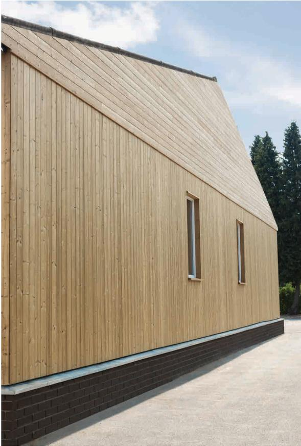
Die unsichtbaren Befestigungen SoftWood Clip™ garantieren ein einfaches und schnelles Verlegen der Fassadenverkleidung, da sie dank ihres integrierten Abstandhalters automatisch einen angemessenen Abstand und eine perfekt parallele Ausrichtung der Paneele gewährleisten.
